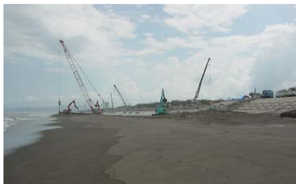
傾斜護岸の工事が進む明神山海岸 (2005.8.3)
