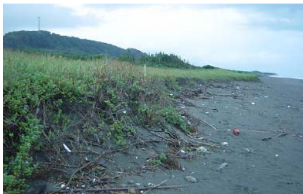
段差が出来た堀の内海岸 (2005.8.7)
